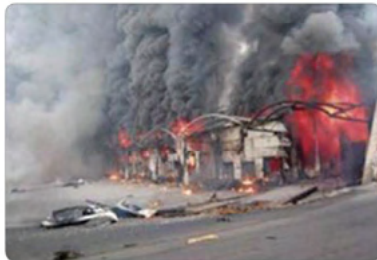
이천 물류 냉동창고 신축공사 화재 ('08.1.7. 사망 40, 부상 10)
