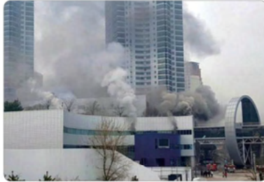
상가 매장 복구공사 중 화재 ('17.2.4. 사망 4, 부상 47)
