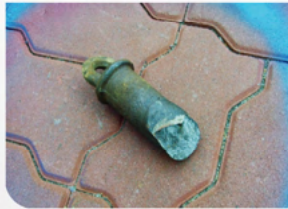
샤클핀 균열 파손
